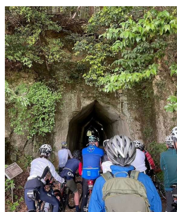
将棋の駒の形の 観音掘り 永昌寺隧道
